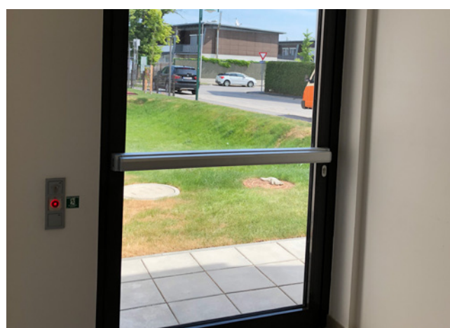
02 Via di fuga sicura: il terminale per vie di fuga TMS Control garantisce un'apertura immediata.
