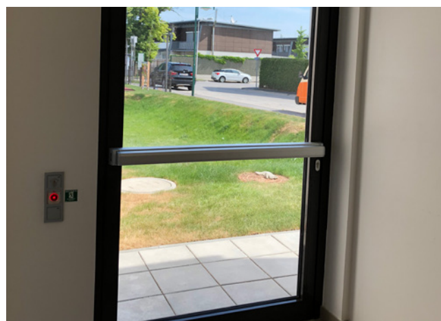
02 Sicherer Fluchtweg: Das Fluchtwegterminal TMS Control stellt die sofortige Öffnung sicher.
