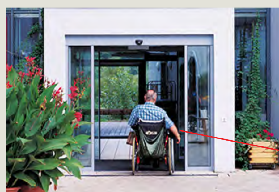
Porta scorrevole automatica associata ad un transponder o ad un trasmettitore/ricevitore.
